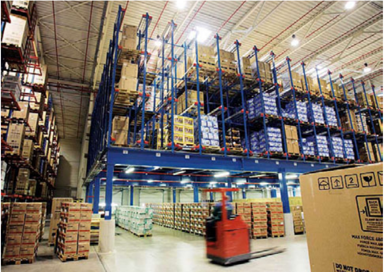
Maxipacker installatie op een staalconstructie
